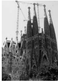
写真-1. 建設中のサグラダ・ファミリア聖堂
