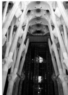
写真-2. 聖堂内部の柱の構造
