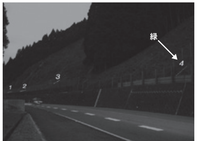
写真2 法面の監視に試験適用
