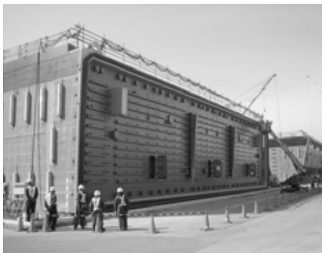
写真9 沈埋トンネル（夢洲トンネル）
