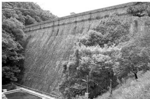
写真－2 布引五本松堰堤
