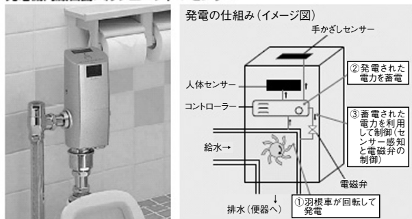
図19 自己発電装置を内蔵した 大便器自動洗浄システム
