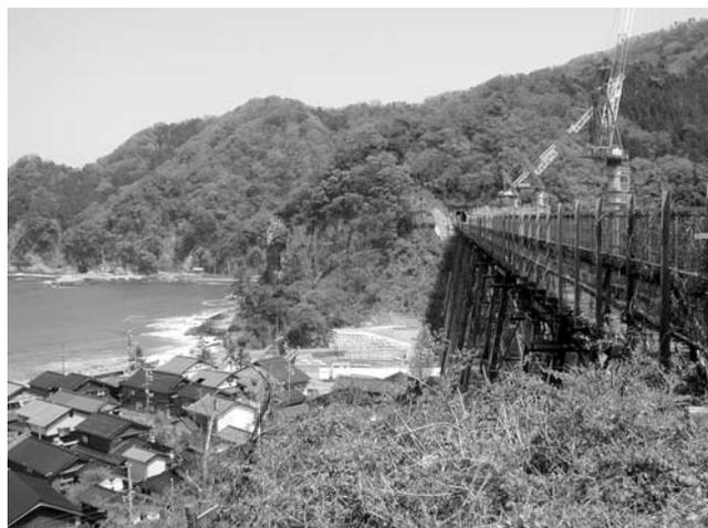
写真1 新橋梁建設のためのタワー・クレーン
