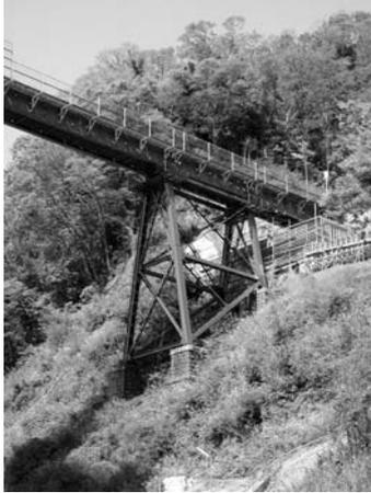
写真6 橋脚基礎の切石積工
