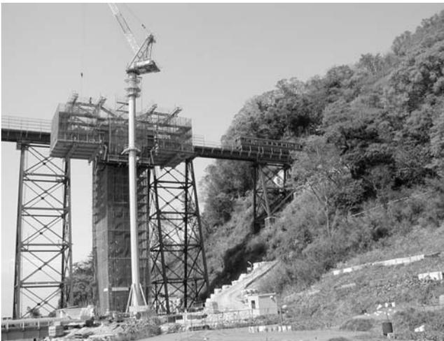
写真7 新橋梁のコンクリート橋脚と橋桁
