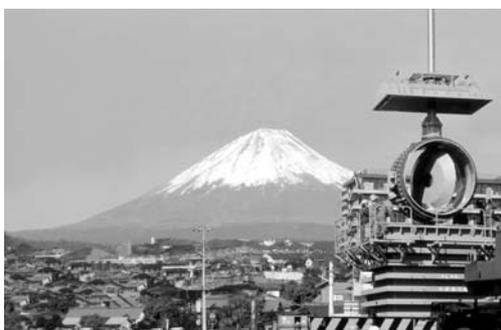
写真-5 通水したまま仕切弁(バルブ)を挿入する不断水インサートバルブ工法
