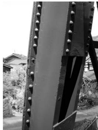
写真3 頭部が欠損した主柱のリベット
