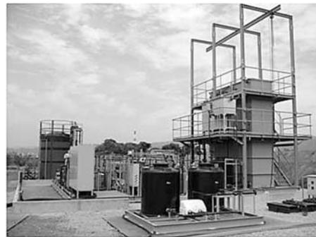
写真9 低動力海水淡水化システム実証設備
