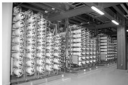
写真1 RO膜（逆浸透膜）ユニット
