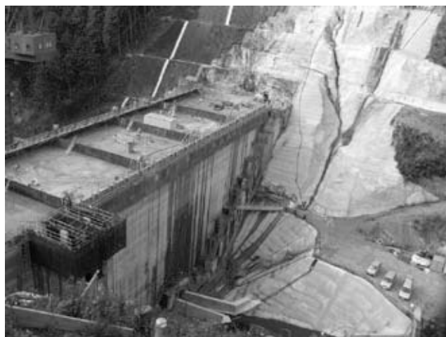
ダム堤体 現状（上流面から）
