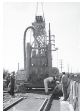
連壁掘削機とF達現場員
