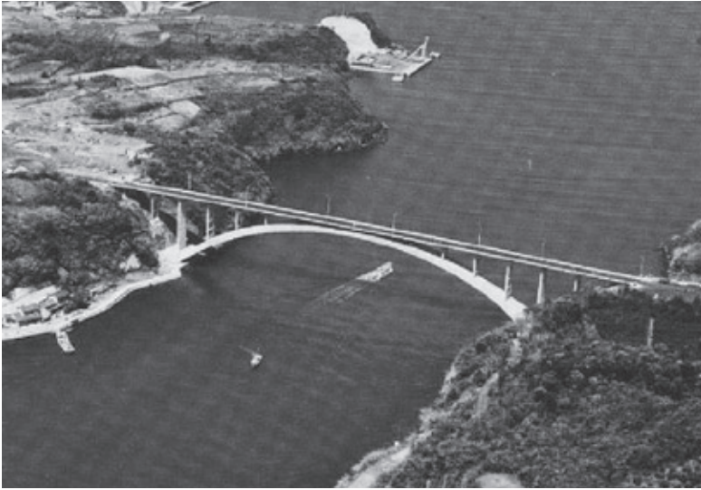
写真-2 外津大橋
