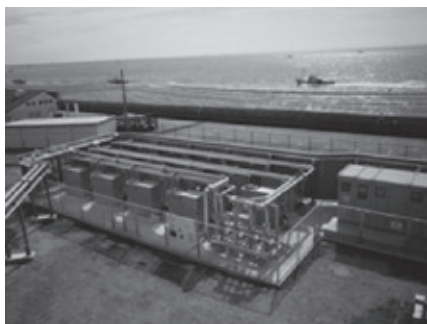
図6 こうべWエコ発電のバイオガス発電設備
