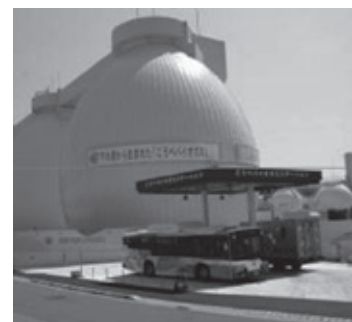
図2 こうべバイオガス供給ステーションと汚泥消化タンク
