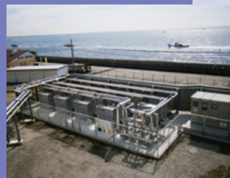
▲こうべWエコ発電のバイオガス発電設備 (本文62頁に掲載)
