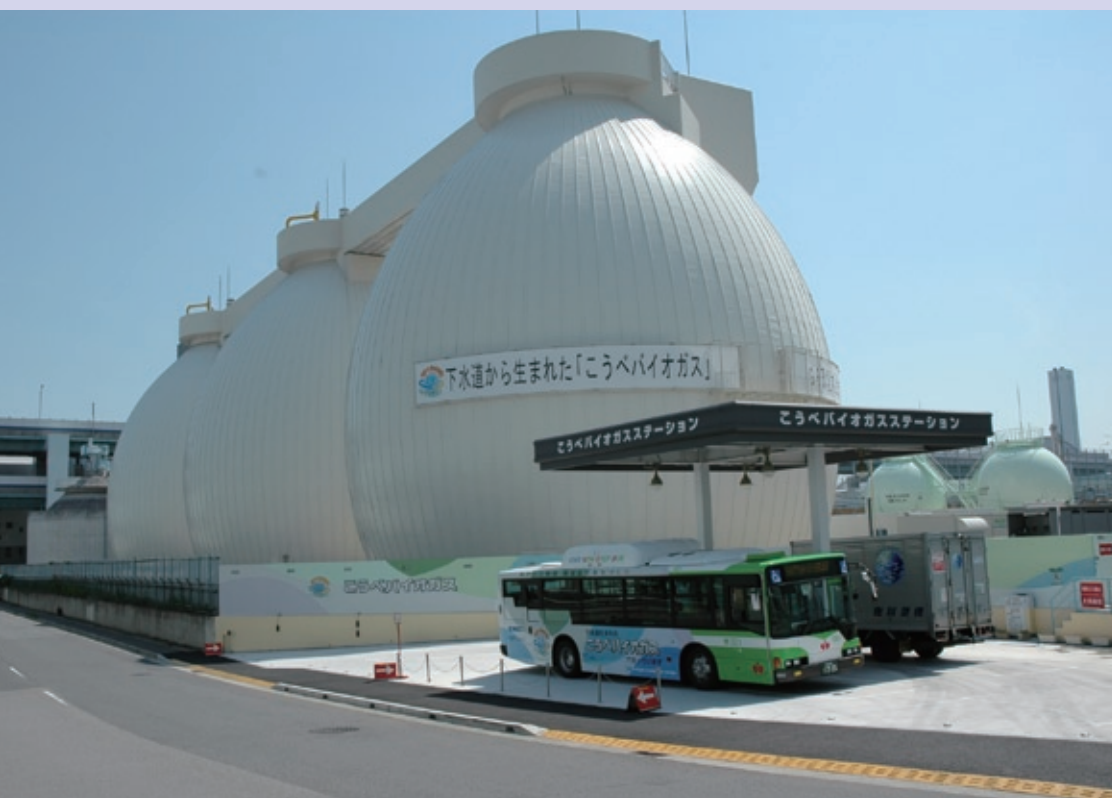
▲こうべバイオガス供給ステーションと汚泥消化タンク(本文60頁に掲載)
