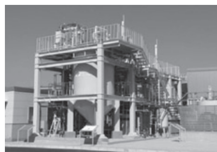
図3 リン回収設備の外観
