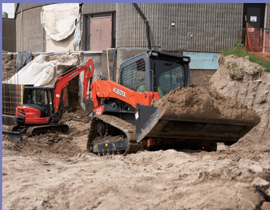
▲わが社の技術:(株)クボタ「北米小型建機ラインナップ化」(右:コンパクトトラックローダ、左:ミニバックホー) (本文46頁に掲載)
