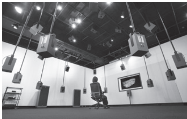
竹中工務店 音響プレゼンテーションルーム 大阪市中央区の弊社1階にある「音響プレゼンテーションルーム」では、開発したシステム“ASPECT”を用いて、計画建物の完成時の響きを実際に聴くことができます。
