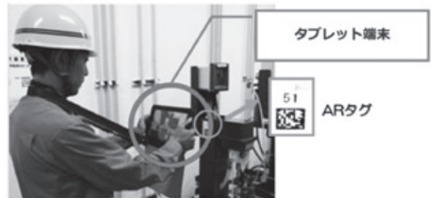
図12 タブレット端末を利用した現場での点検作業
