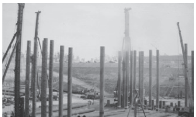
神戸ポートアイランドの建築物と杭打ち状況
