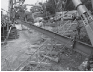
図9 基礎梁取り付け
