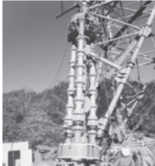
図12 主柱材のジャッキアップ装置取り付け
