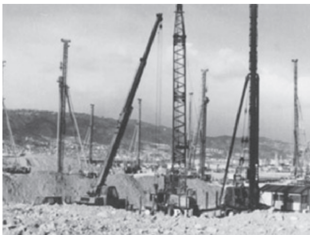
サンドドレーンの打設状況（1977年）
