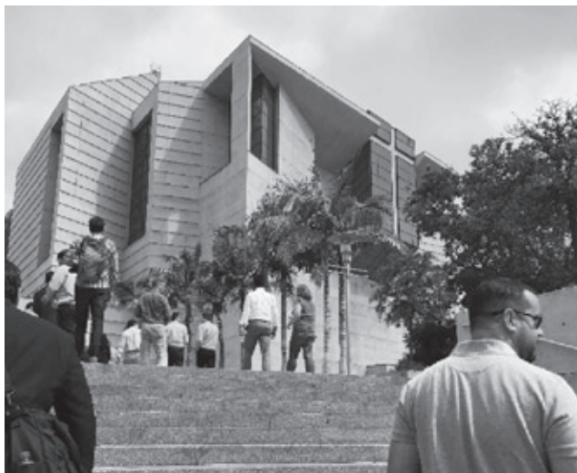
PREEMPTIVE workshopでの免震建物見学の様子
