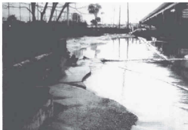
兵庫県南部地震時の神戸ポートアイランドの状況
