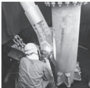
図14 ガセットプレートの現場溶接
