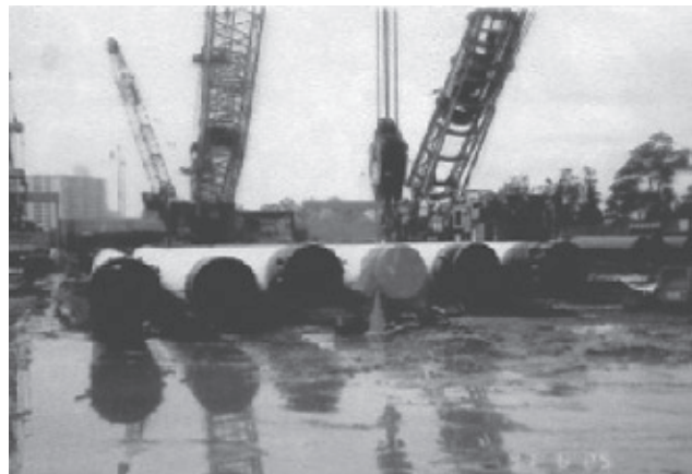
鋼管巻きSL処理杭
