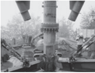
図11 腹材、ガセットプレートの切断
