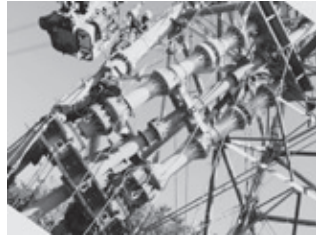
図10 腹材のジャッキアップ装置による応力除去
