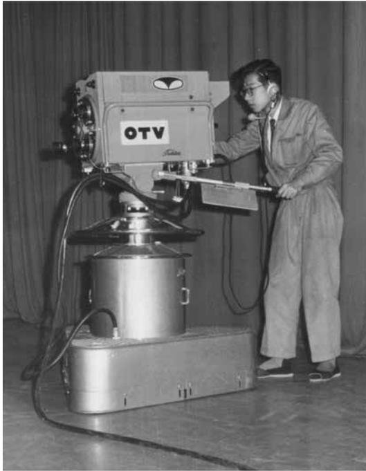
それでカメラの調整に技術者が付きっきりだった。太くて重いケーブルの繋がったカメラをベデスタルという台車にのせて移動しながら撮影した。それを副調整室にいるスイッチャーさん（技術者が担当）が切り替えてドラマやコマーシャルを生放送する。レンズも今のようなズームレンズではなかった。4種類の焦点距離の異なるレンズを撮像管の前でターレットに付けて瞬時に切り替えて画角を調節した。
