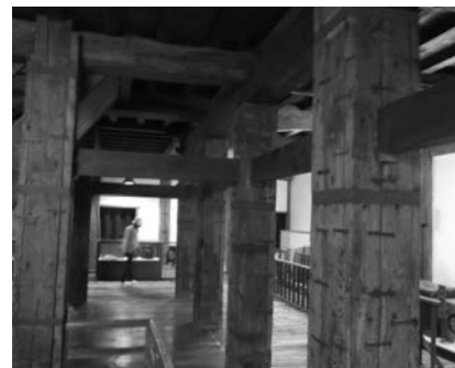
松江城天守の柱補強状況
