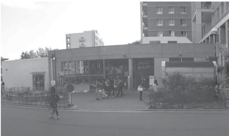
図3 改修予定の工学部食堂（工学部玄関より、平成26年7月1日）
