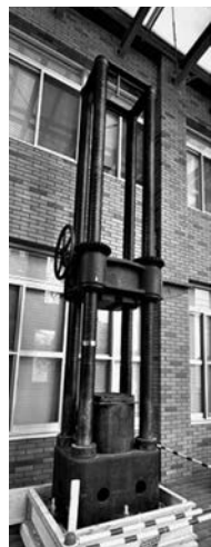
写真1 保存工事中 モニュメント500tf圧縮試験機(足立先生撮影、2021.4.2)
