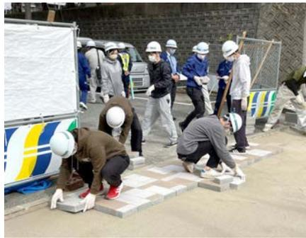
写真1 2021年度有野台団地外部空間整備。ブロックの敷設作業に学生が参加。
