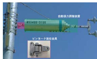
図11 ピンヨーク装柱金具
